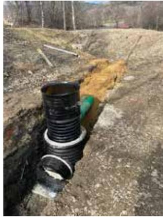
Einbau Sedimentationsanlage am Rückhaltebecken am Gewerbegebiet „Am Bauhof III“
