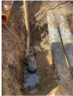
Rohrbruch Hauptwasserleitung Fürholz
