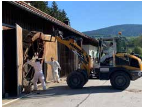
Reparatur Wellenzapfen an einem Scheibentauchkörper in der Kläranlage
