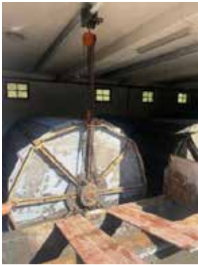
Reparatur Wellenzapfen an einem Scheibentauchkörper in der Kläranlage
