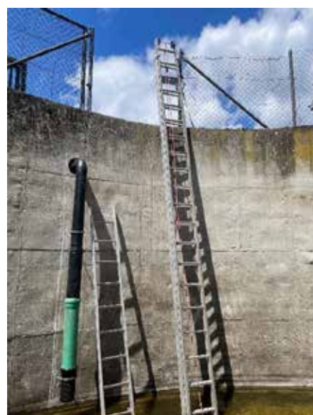
Umfunktionierung einer Güllegrube zur Löschwasserzisterne Exenbach-Kronwinkel
