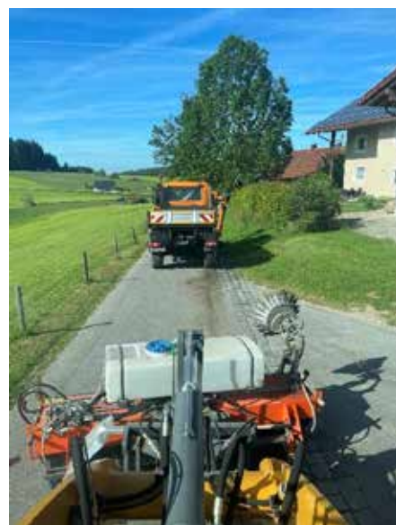
Säuberung der Wasserführungen im ganzen Gemeindebereich
